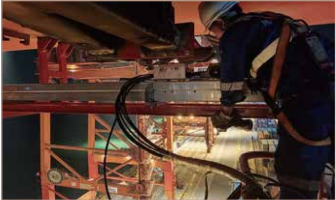
深圳SCT港区QC29岸桥拖令升级改造项目
