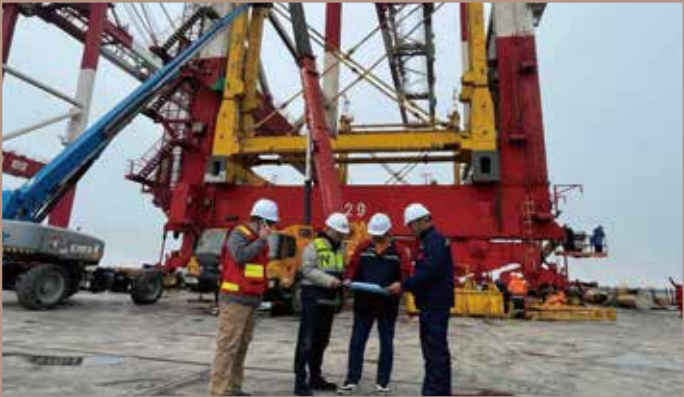
上海冠东3台岸桥加高及大修项目
