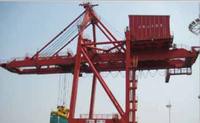
马鞍山天顺港45T-24M集装箱桥吊
